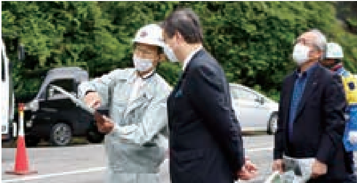
令和4年5月 国道169号川上村大迫地内崩落箇所にて
